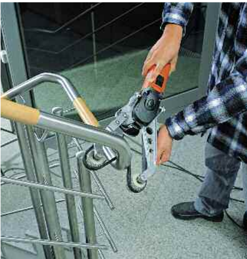
Bilder 20 + 21: Mit Handschleifgeräten lassen sich auch feine Arbeiten wie die Wiederherstellung eines gleichmäßigen Schliffbildes oder das Nacharbeiten von Schweißnähten problemlos durchführen – auch an Rohren und in Gehrungen
