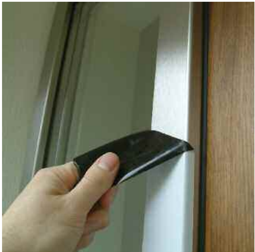
Bild 22: Die partielle Folienbeschichtung erleichtert auch das spätere Abziehen der Schutzfolie
